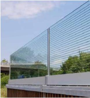
Bild 9: Schwarze, horizontale Linien von 2 mm Breite und einem Lichtmass von 28 mm schnitten in Laborversuchen wider Erwarten sehr gut ab. <sup>1</sup> [Archiv Schweizerische Vogelwarte]
