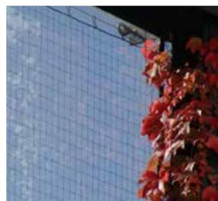
Bild 5: Diese gläserne Lärmschutzwand wurde mit feinen Drahtnetzen sichtbar gemacht.<sup>3</sup>
