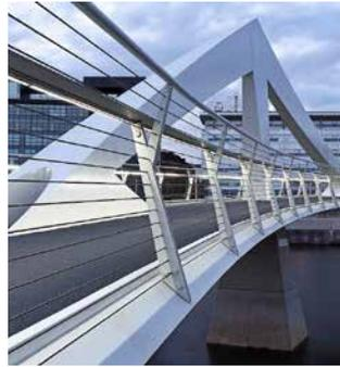
Bild 10: Vergleichbare Lösung der Jakob Rope Systems: Horizontale Seile als Geländerfüllung auf einer Fussgängerbrücke in England.
